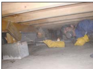
床下木材に薬剤吹付け
