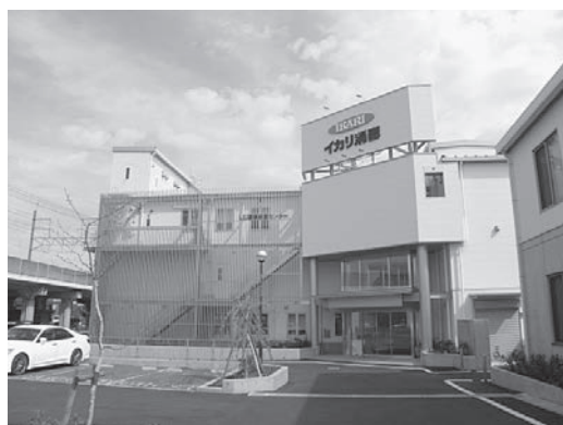
LC環境検査センター建物
